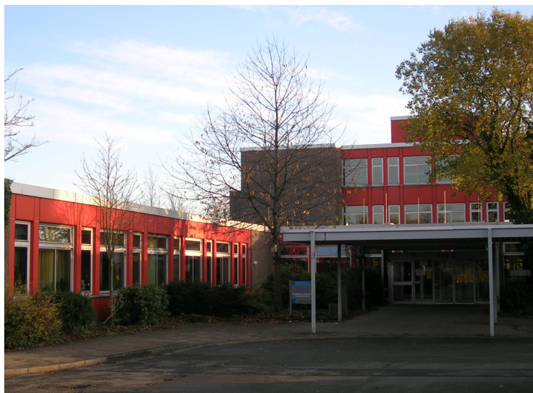
Foto des aktuellen Eingangs- und Empfangsbereichs
