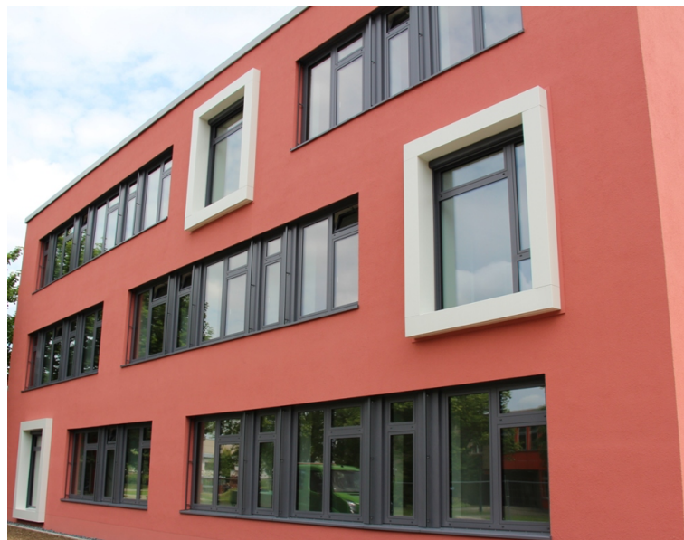
Foto des frisch sanierten Gebäudeteils
